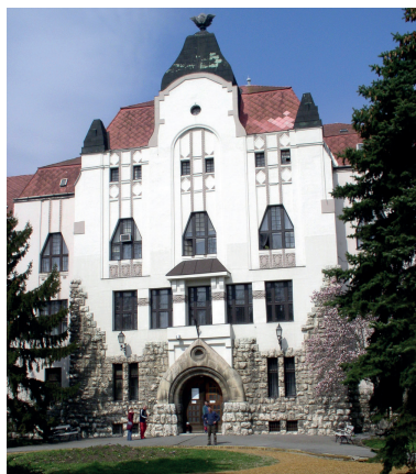
MÁV területi Igazgatóság, Pécs - homlokzat felújítása
