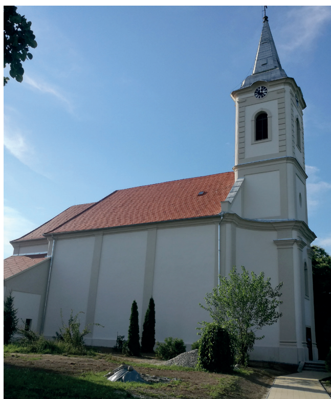
Szent Anna templom, Kocsola homlokzat felújítás
