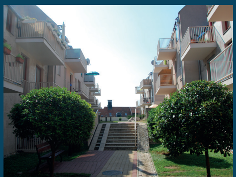
Minerva Lakópark, Pécs műszaki ellenőrzése
