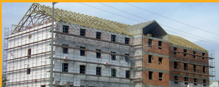
Törökbálint szálloda, szeglemezes tetőszerkezet készítés, tetőfedés
