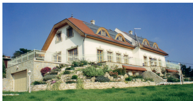
Ikerház, Szentendre, építés
