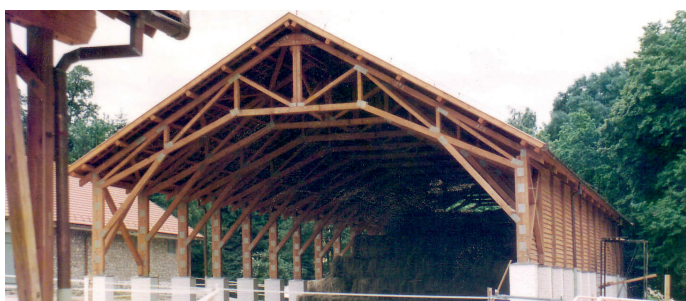
Lovarda, szénatárolók, Szépalmapusztá- faszerkezetek készítése, tetőfedés
