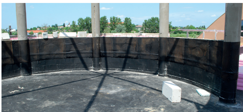
Tamási Termálfürdő terasz és tető szigetelés
