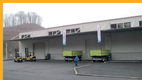
Fliegl csarnok, Komló építés
