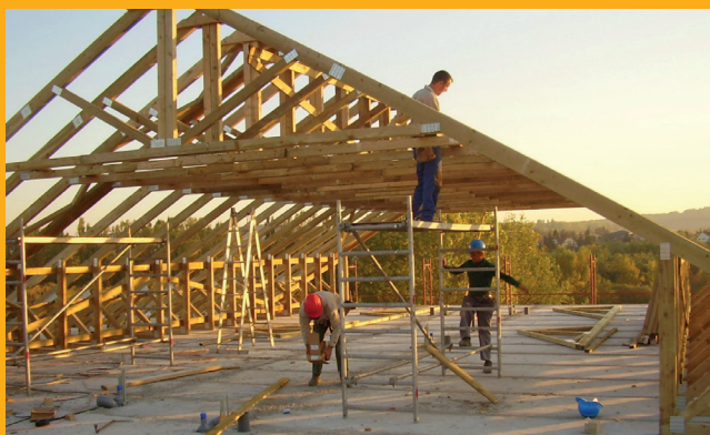
Törökbálint szálloda, szeglemezes tetőszerkezet készítés, tetőfedés
