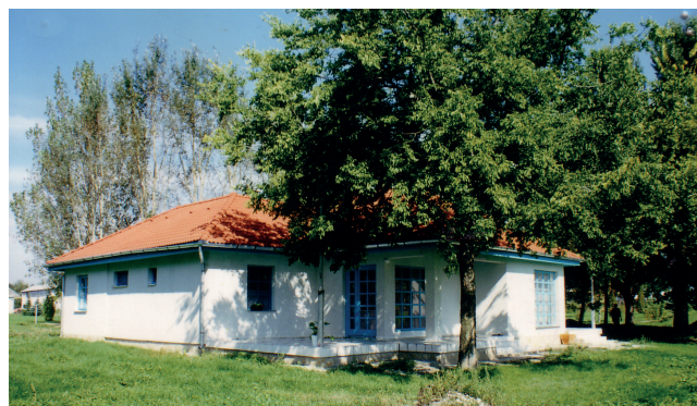
Családi ház, Gyál - építés
