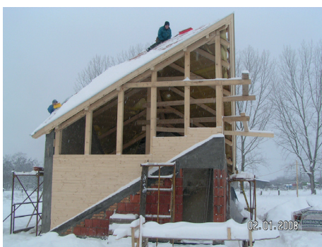
Duna-Dráva Nemzeti Park túra állomások faszerkezetek készítése, tetőfedés
