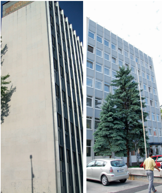
Kaposvári Járásbíróság homlokzat felújítás és nyílászáró csere
