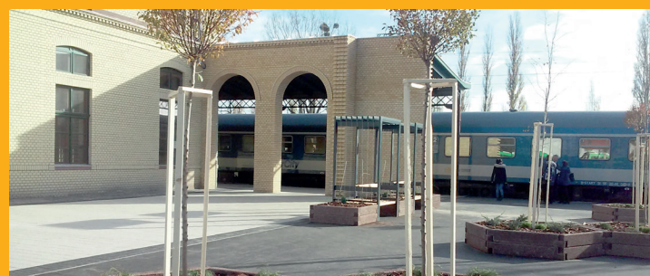
Vasútállomás, Pécs - épületfelújítás
