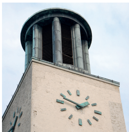
Szent Kereszt felmagasztalása templom, Balatonboglár Bauhaus templomtorony rézlemez fedése
