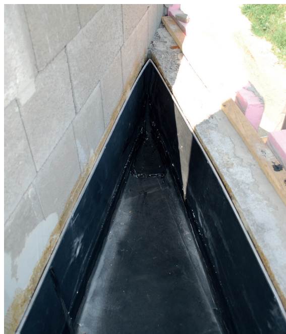
Tamási Termálfürdő terasz és tető szigetelés
