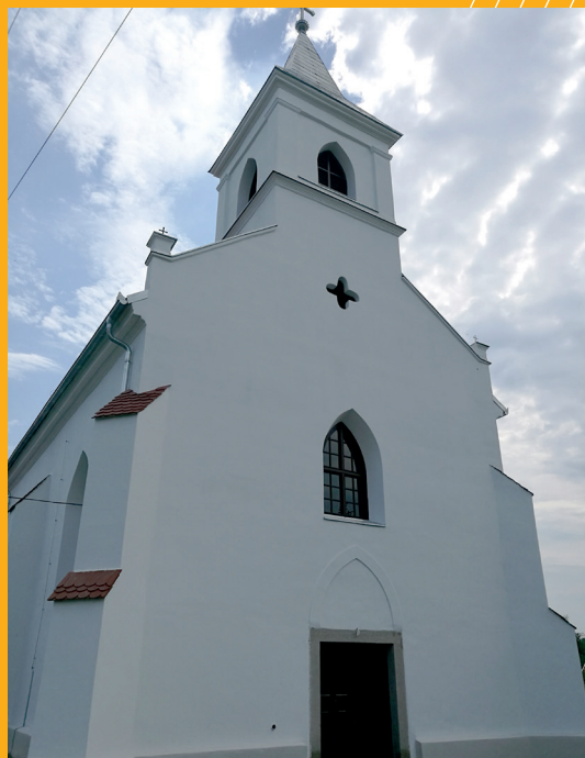
IX. Szent Lajos király templom, Felsőnyék teljes felújítás
